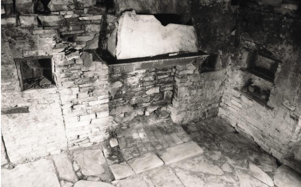
Fig. 2 - Particolare della Caminata di Camaré , la stanza più antica, prima della ristrutturazione.
