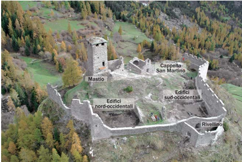
Fig. 1 - Ripresa dall'elicottero del Castello di Graines a fine lavori di scavo e restauro, ottobre 2012 (A. Sergi).
